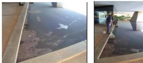
Figura 2: Arraste de detritos em um espelho d'água de 888 m<sup>2</sup>, cuja superfície foi limpa em um período cerca de 5 vezes menor do que o usual.
