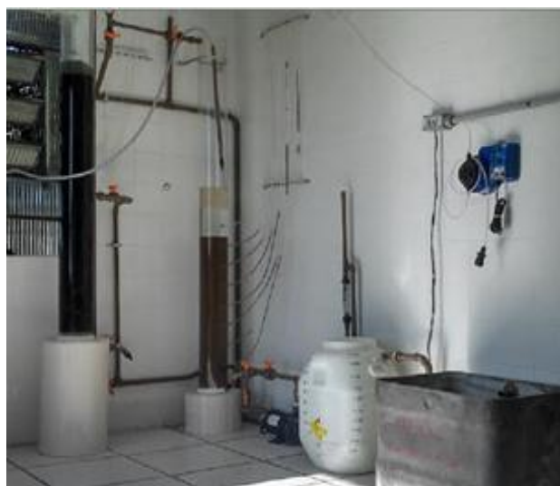
Fig. 1: Unidade piloto de dupla filtração.
